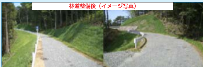
林道整備後(イメージ写真)
