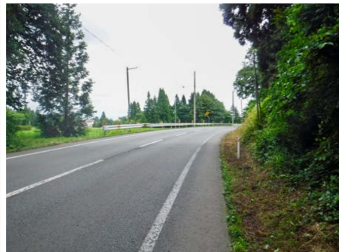
② 主要地方道盛岡和賀線・大瀬川地区（歩道整備）
