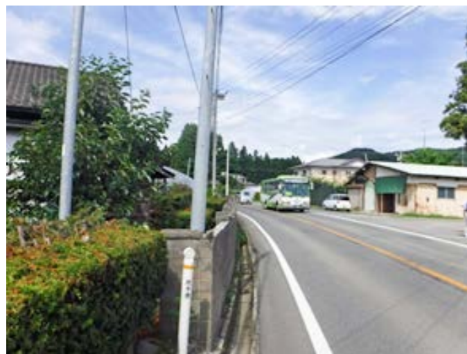
① 一般県道 羽黒堂二枚橋線・滝田地区（歩道整備）
